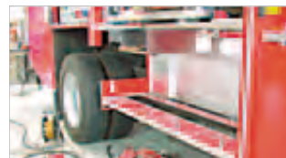
Travaux d'entretien, réparations et travaux de carrosserie.
