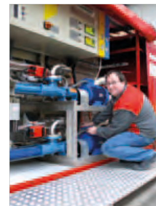
Rééquipement et modification électrique (y compris les systèmes SPS).
